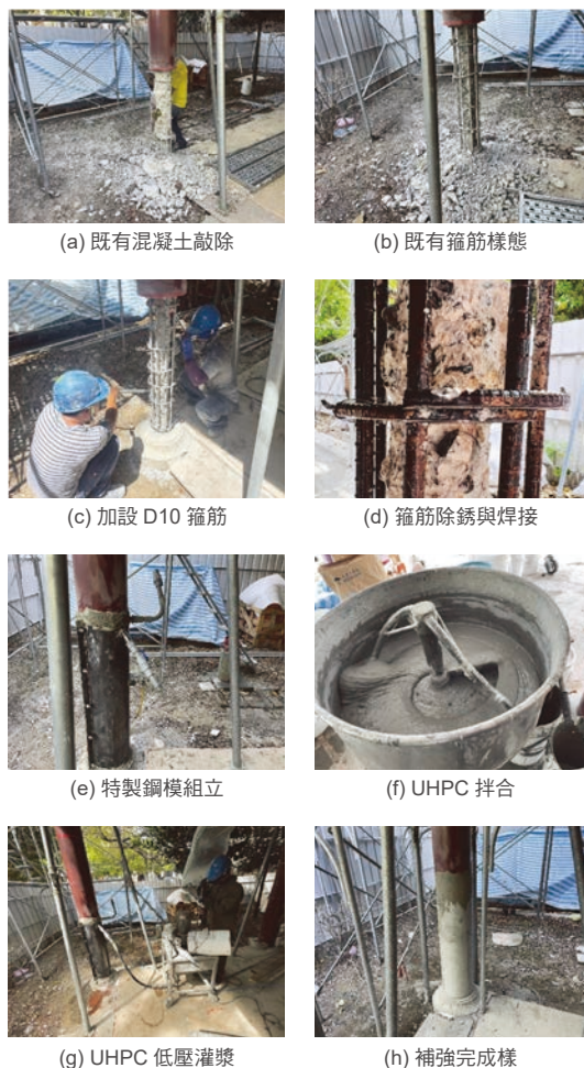
圖 5 UHPC 包覆補強施工
