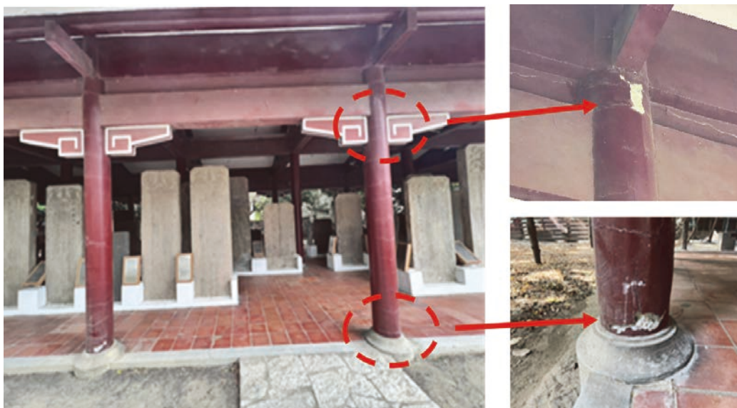
圖 3 既有柱損壞樣態
