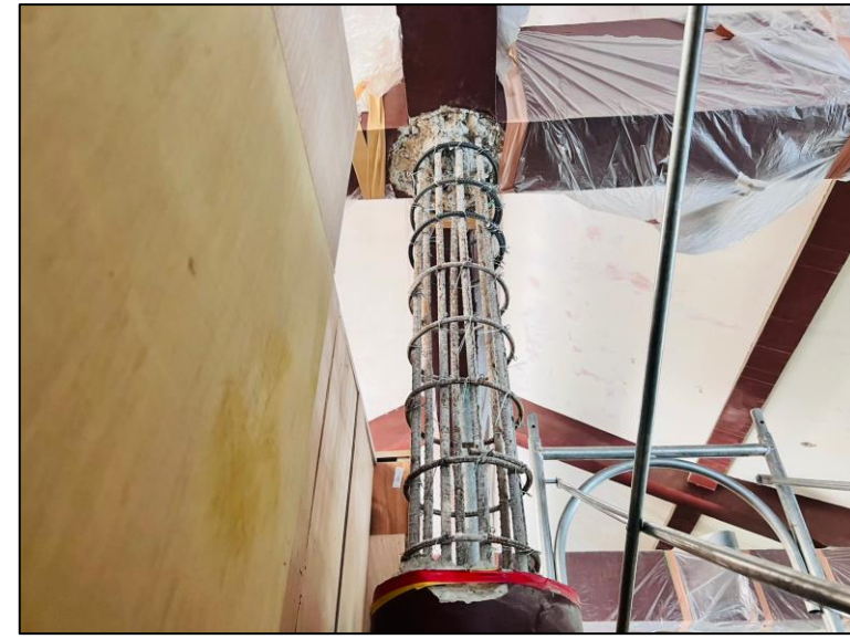
步驟2-2.端部新增設3組箍筋
