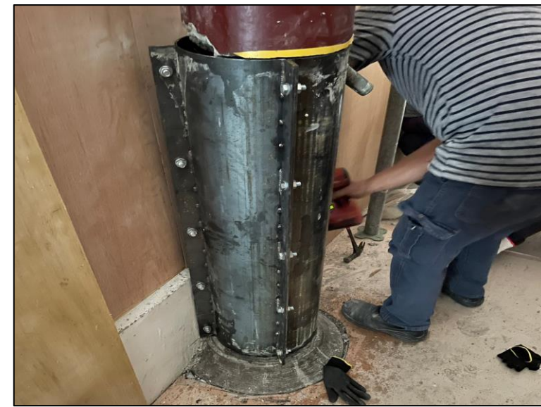
步驟3-2.鋼模鎖固中
