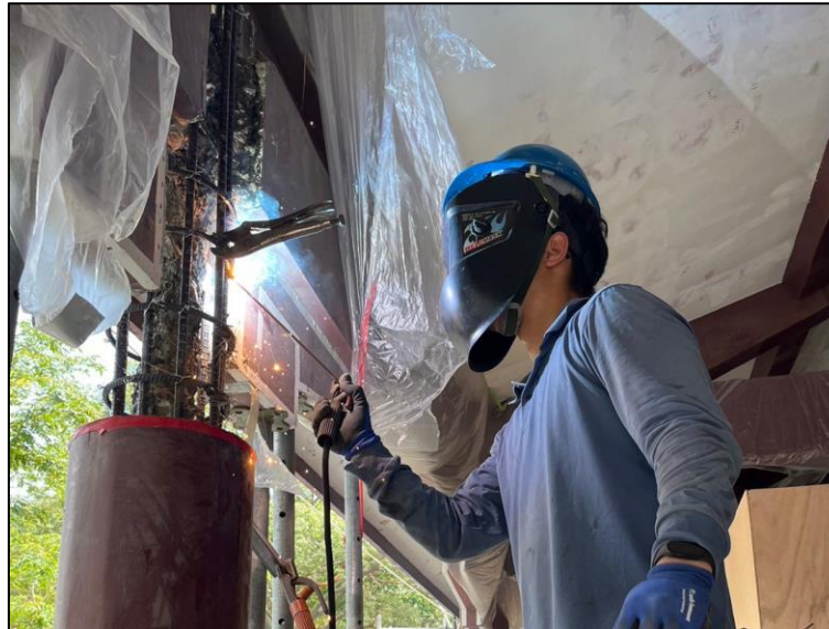
步驟2-3.箍筋點焊固定
