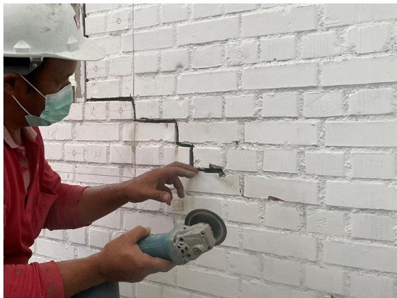
1. 將灰縫產生裂縫的部分清除
