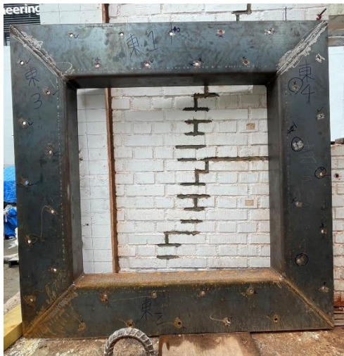
1. 鋼框補強構件
