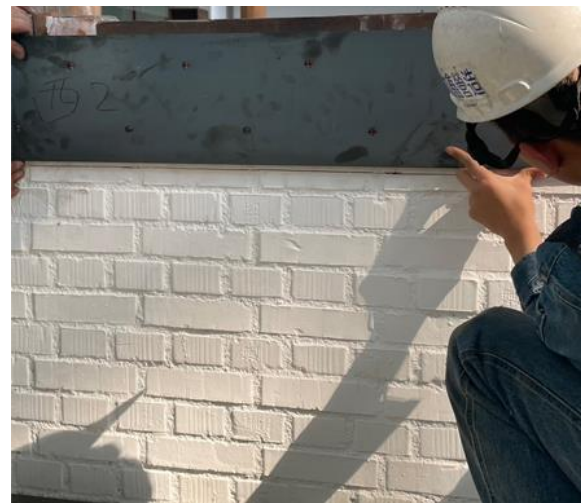
3. 標記預鑽孔位於磚牆牆面
