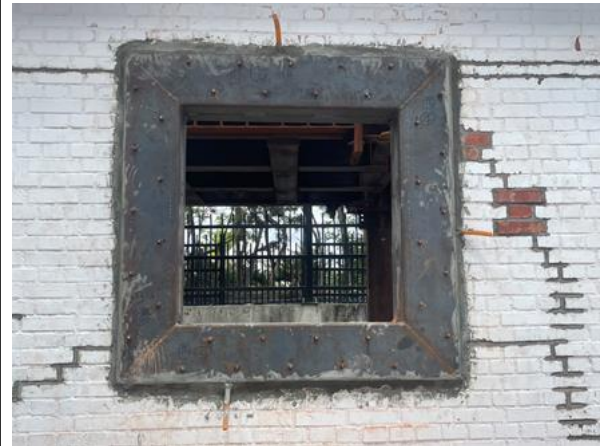
19.預埋無收縮水泥砂漿溢流、注入 管
