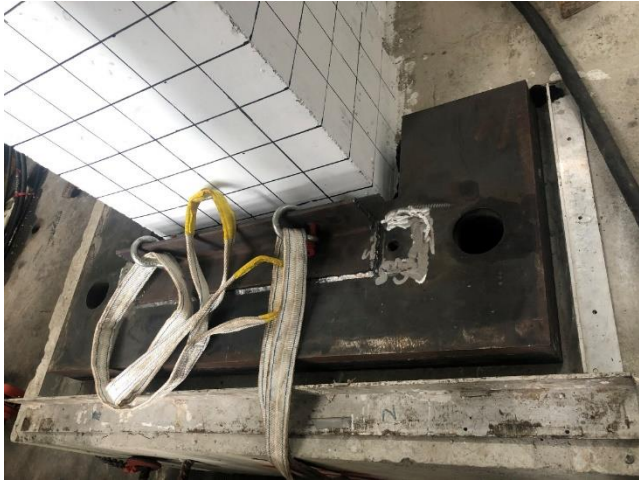
基礎加固鋼板
