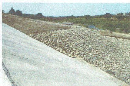
照片 1-2 河床之坡面工
