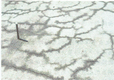
照片 1-15 公有建築樓板貫穿裂縫
