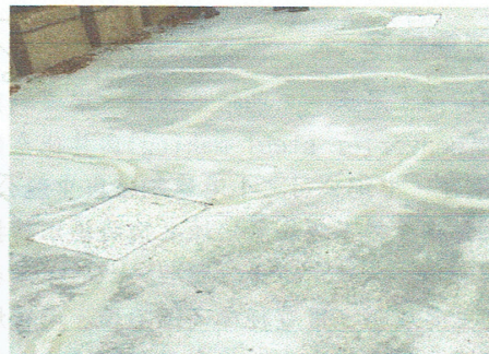
照片 1-16 鋼筋混凝土結構地坪之全面裂損
