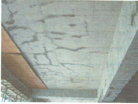
照片 1-13 公有建築樓板貫穿裂縫
