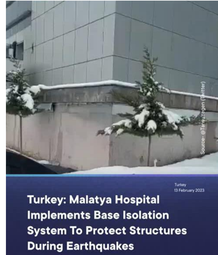
地震時建築作動紀錄 勘災點23
